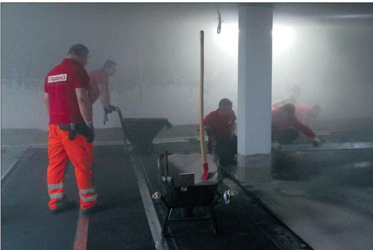
Einbringen der Asphaltdecke in Tiefgarage
