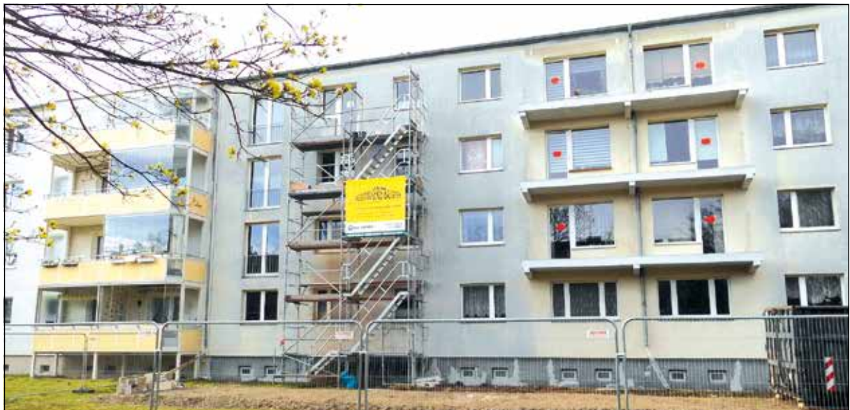
Entfernung der Balkonbrüstungen
